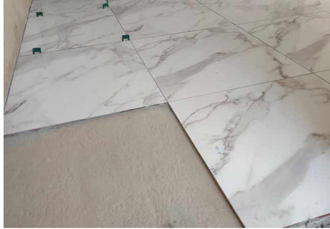
Figura 35: Cerâmica sendo instalada no piso.
